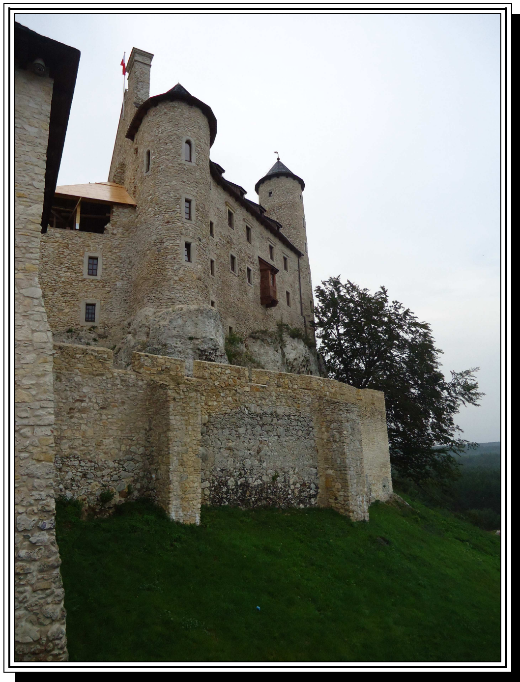
Zamek w Bobolicach po renowacji – foto Fundacja QUOMODO
